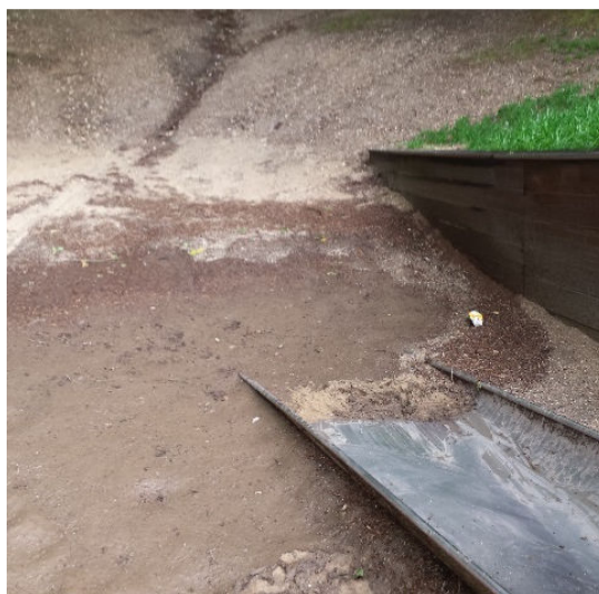
Figuur 8: achtergrond: erosiegeul zichtbaar, voorgrond: leem afzetting in de kuil wat een stuk de glijbaan in is gespoeld.
