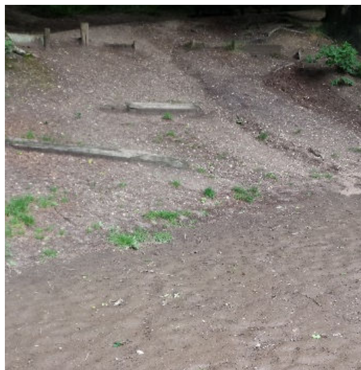
Figuur 7: Midden bovenin de foto: houten erosiebescherming die is weggerot en verzakt, Rechtsboven: erosie geul zichtbaar, Voorgrond: afzetting in drainzand.
