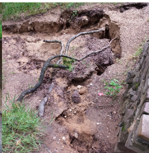
Figuur 9: diepe erosiegeulen zichtbaar naast de oude muur.
